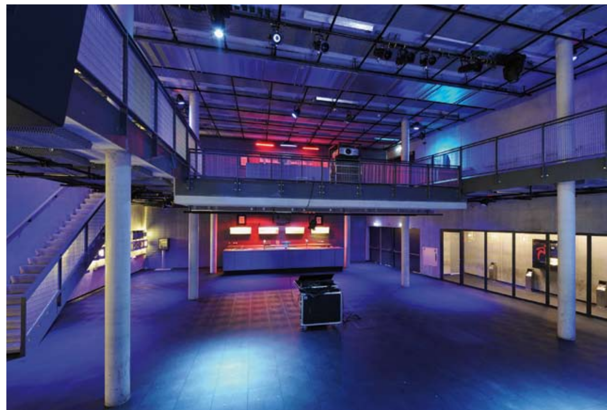
Een lastige ingreep was het inpassen van twee lagen voor het balkon in de zaal en in de foyers. Hiervoor is inpandig anderhalve meter ontgraven.
