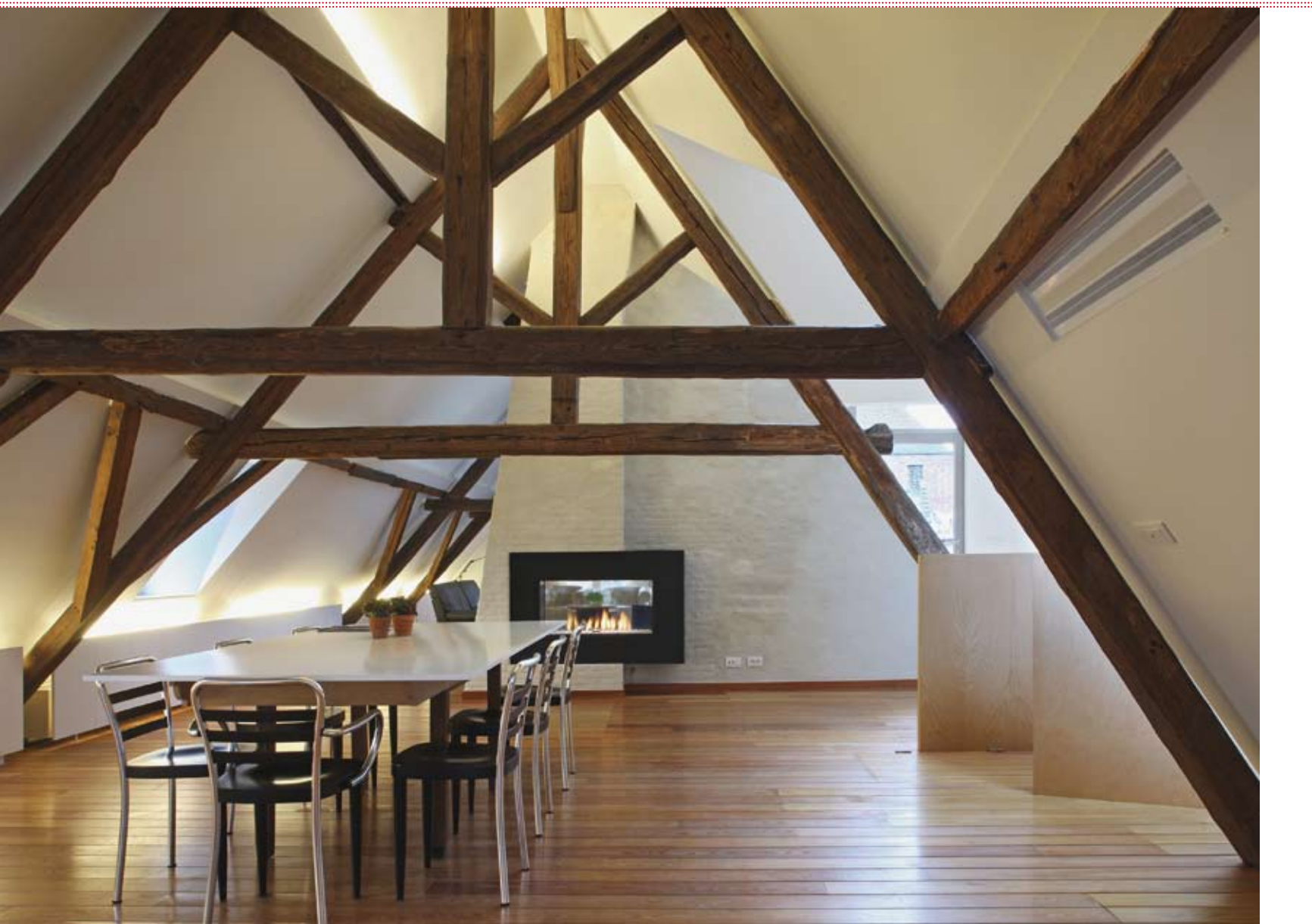
De ruimtelijke ervaring op de zolderverdieping wordt versterkt door de beglazing onder het zaagtanddak, die in overleg met Monumentenzorg is aangebracht.
